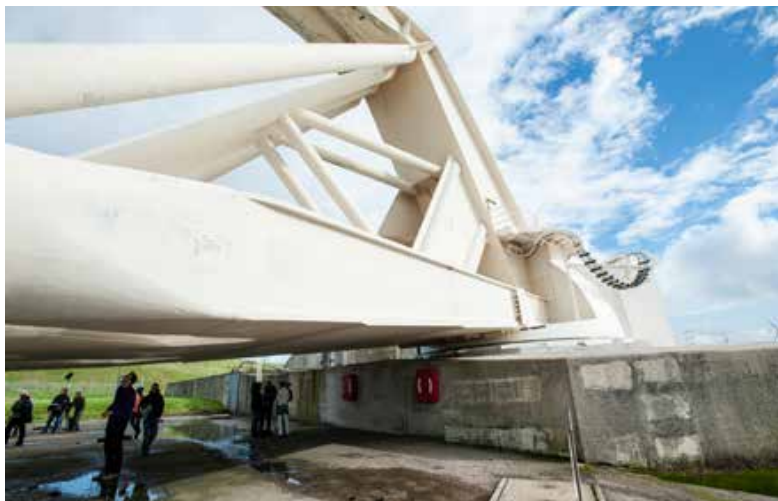
Beide armen van de Maeslantkering eindigen in een stalen bolscharnier met een diameter van 10 m en 680 ton gewicht. De bol beweegt op 10 holvormige schalen waarin zo'n 500 schijven in 'Ultra High Molecular Weight Polyethyleen' of UHMW-PE zijn aangebracht. (Foto: LDS)
