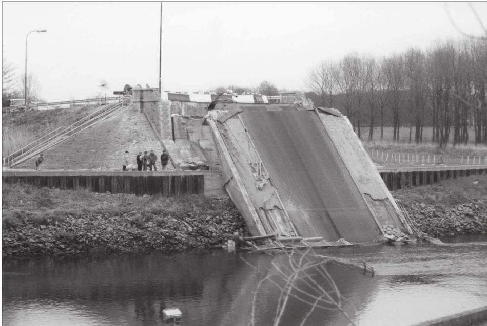
Figuur 1.15. Ingestorte brug te Melle (1992), België.
